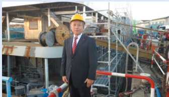
建造中の学習船「うみのこ」を視察
